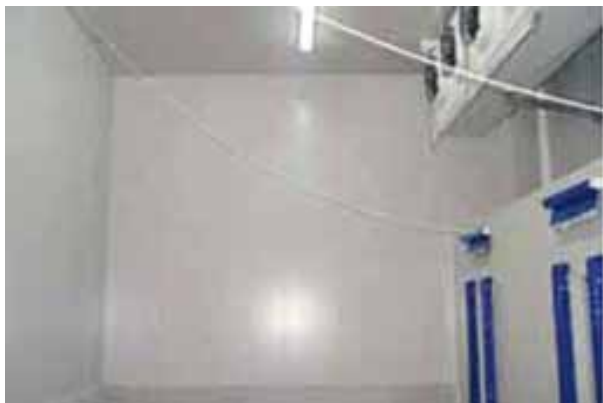
Celle frigorifere realizzate con pannelli Isofrigo.
